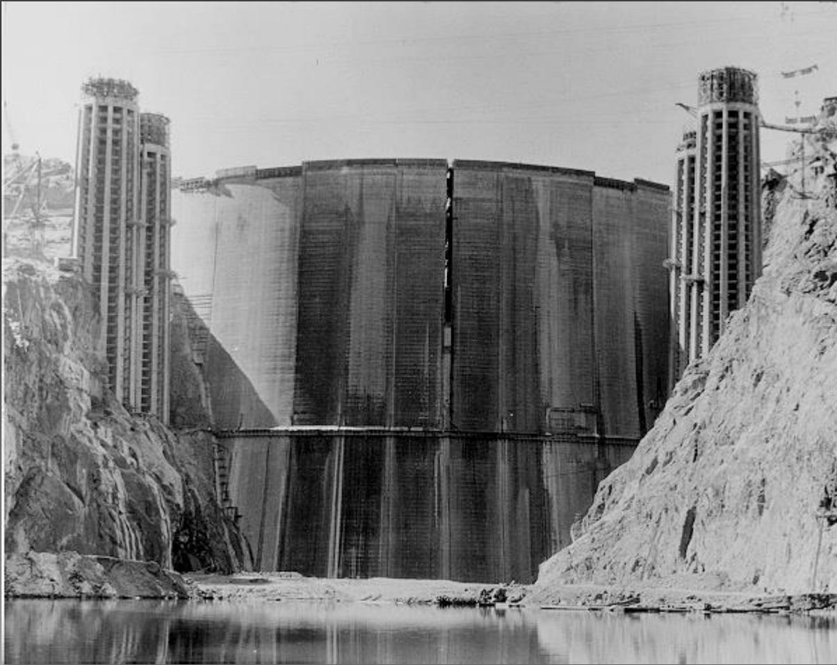
Il primo caso riconosciuto di correlazione tra aumento di sismicità e riempimento di una diga è quello della diga di Hoover (USA), profonda 191 m, che generò sismicità con  $M_{\max}=5.0$  il 4/5/1939.
