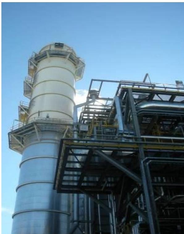
**Figura 11: In primo piano, il generatore di vapore a recupero con sfiato di vapore acqueo. In secondo piano, il camino di emissione di un turbogas**
