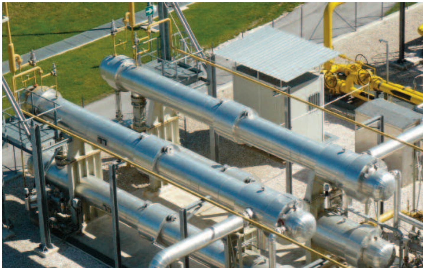
Fig. 8 - Gli scambiatori di calore presso la stazione di arrivo del gas naturale. Hanno il compito di innalzare la temperatura del gas naturale prima dell'ingresso in turbina.
