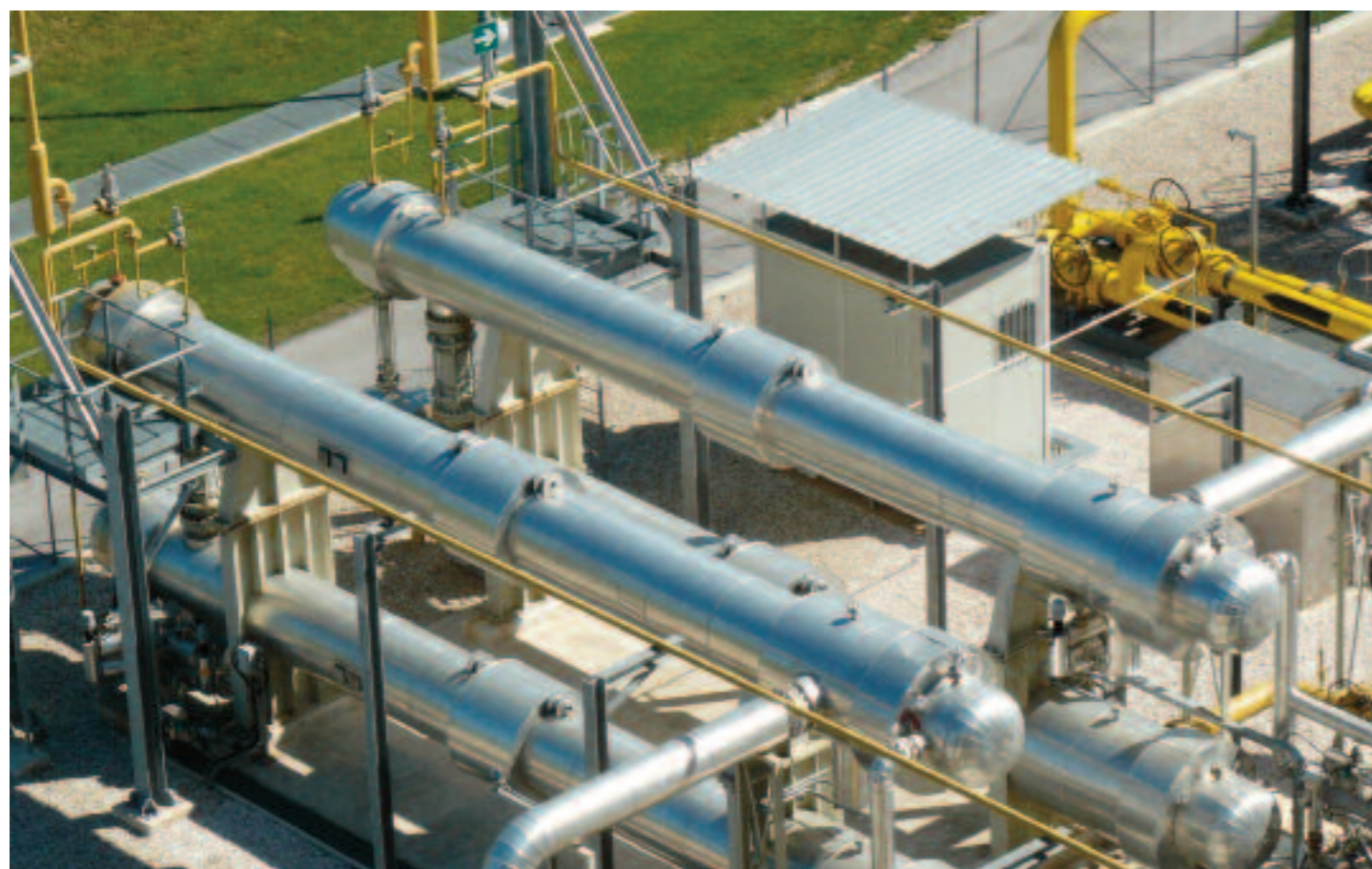
Fig. 6 - Gli scambiatori di calore presso la Stazione di arrivo del gas naturale. Hanno il compito di innalzare la temperatura del gas naturale prima dell'ingresso in turbina.
